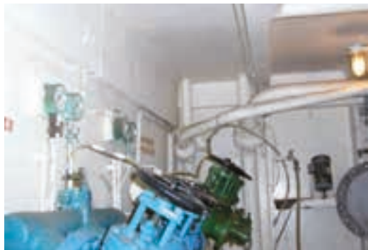
El amianto se usaba para recubrir falsos techos acústicos, térmicos y tabiques ligeros.
