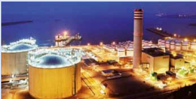
Puerto de Bilbao, vista del atraque de Bahía Bizcaia Gas y el pantalán de Punta Ceballos.
