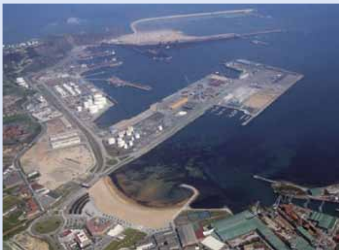
La planta regasificadora de El Musel tiene una capacidad de 300.000 m 3 de GNL y pueden atracar buques hasta 266.000 m 3 .
