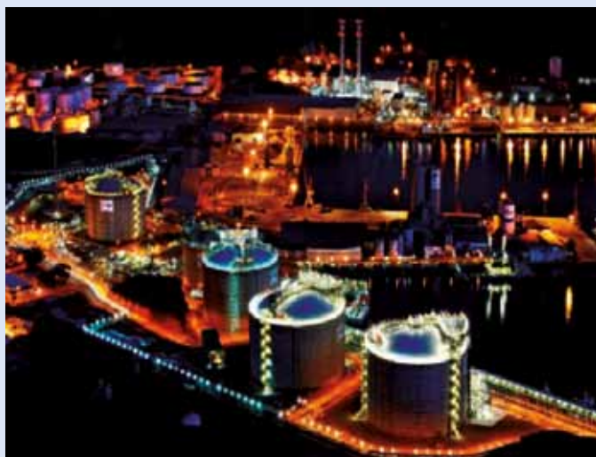
Desde 2009, en la dársena de Escombreras pueden descargarlos gaseros más grandes del mundo, de hasta 266.000 \text{ m}^3 .
