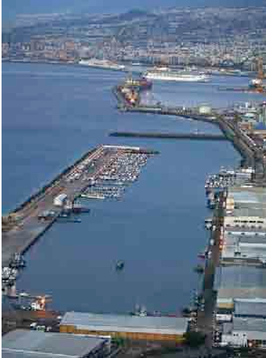
La Autoridad Portuaria de Santa Cruz de Tenerife actualmente gestiona bajo su competencia los puertos de Santa Cruz de Tenerife, Santa Cruz de La Palma, Los Cristianos, San Sebastián de La Gomera y La Estaca
