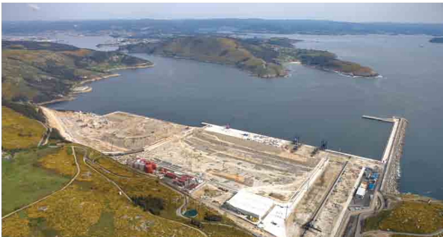
Obras de ampliación del puerto de El Ferrol, A Coruña
